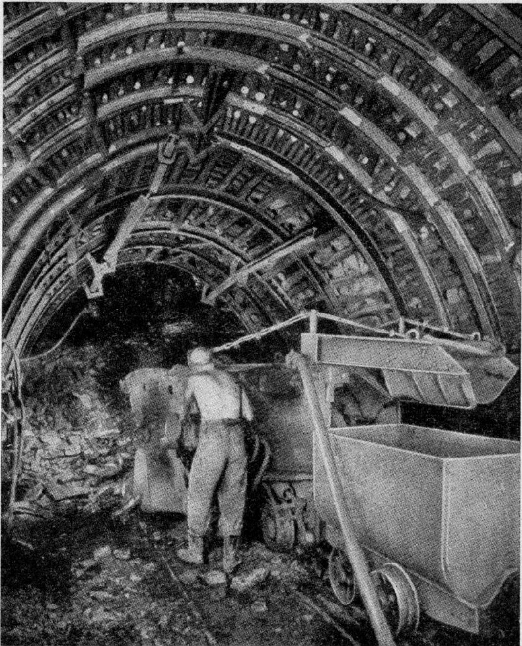
Streckenvortrieb mit modernen Maschinen und Stahlausbau
