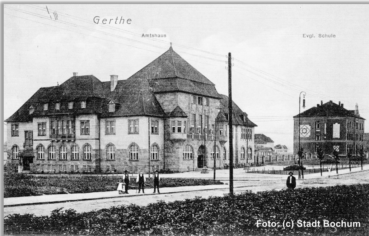
Abbildung 22: Gerther Amtshaus mit Polizeiwache, rechts: Ev. Volksschule an der Heinrichstraße (Foto: (C) Stadt Bochum)
