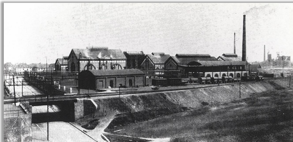
Abbildung 27 Eisenbahnbrücke an der Kircharpener Str. / "Kleine Chemische Werke" der Zeche Lothringen I/II (Foto Archiv Kohlengrüberland)
