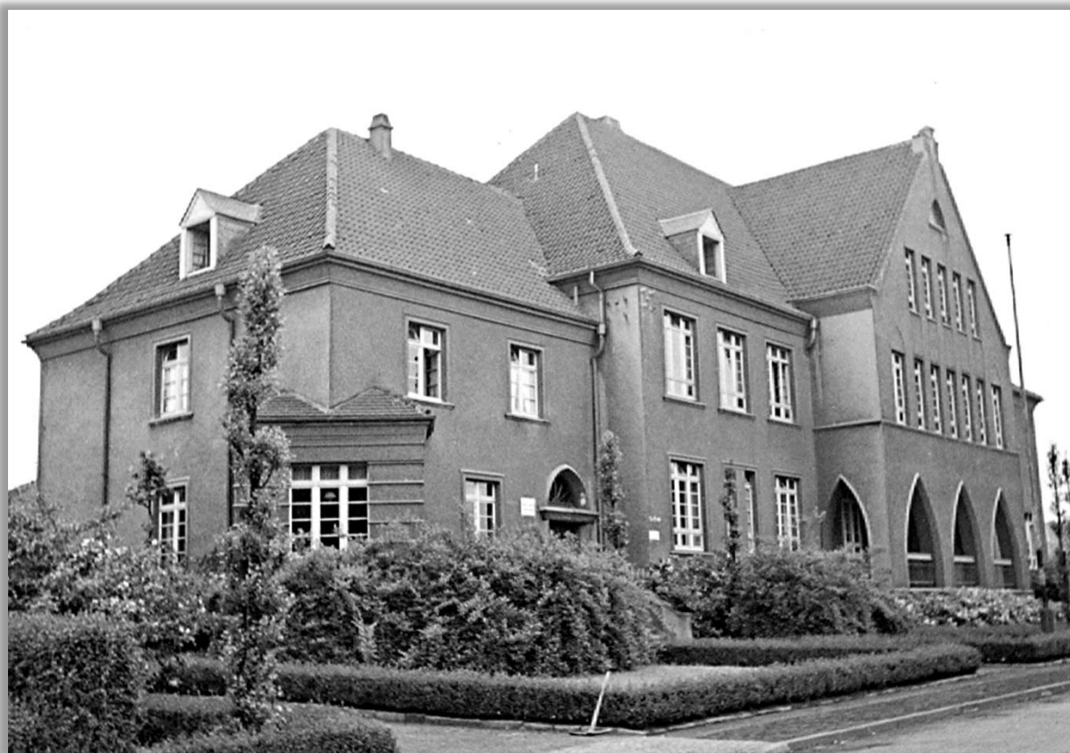
Abbildung 62 Ehemalige Hegelschule 1937, Standort des "Gerther Blutkellers" der SA (Foto © Stadt Bochum)
