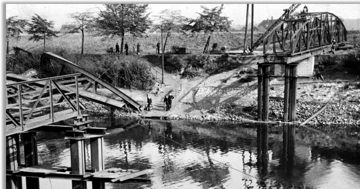
Abbildung 21 Gesprengte Kanalbrücke an der Recklinghauser Str., Mai 1945 (Foto © Bildarchiv der Stadt Herne)
