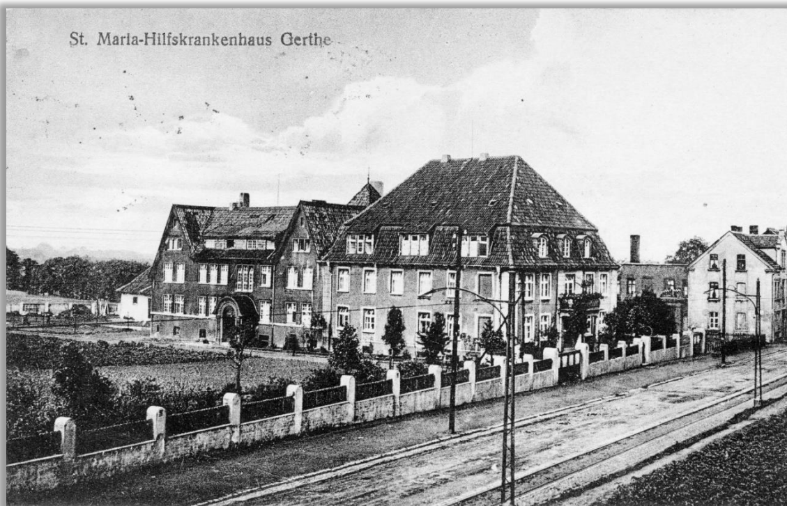
Abbildung 2 Ursprungsgebäude des St.Maria-Hilf-Krankenhauses in den 1920er-Jahren (Foto © Stadt Bochum)
