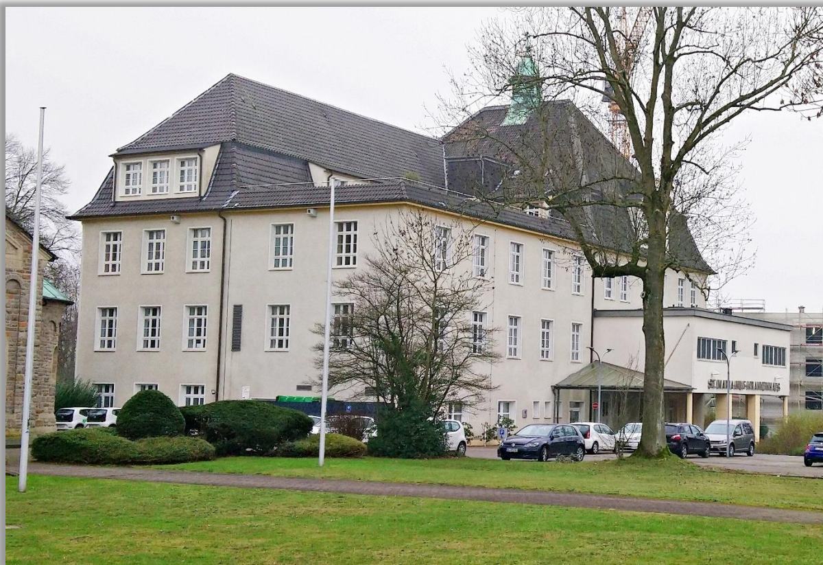
Abbildung 27 Das Gerther St. Maria-Hilf-Krankenhaus mit Erweiterungsbauten im Februar 2023 (Foto © Kohlengrüberland)
