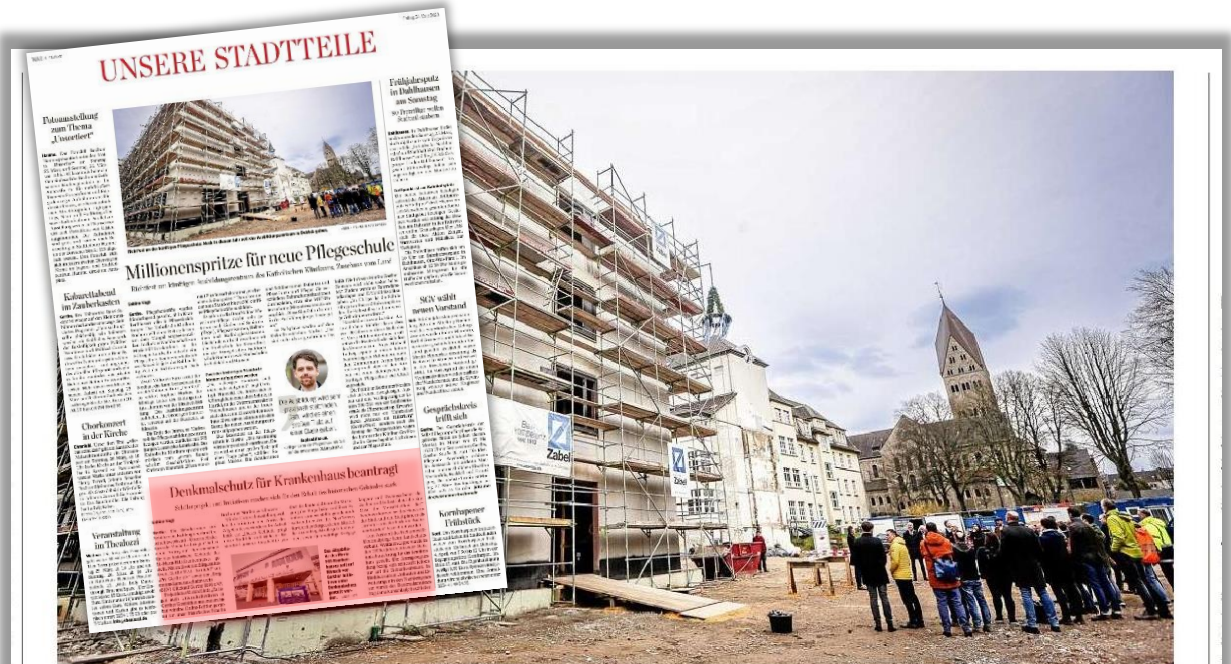
Richtfest an der künftigen Pflegeschule: Noch in diesem Jahr soll das Ausbildungszentrum in Betrieb gehen. ANDRÉ HIRTZ/FUNKE FOTO SERVICES
