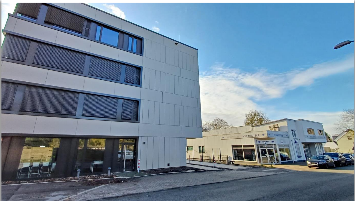
Abbildung 41 Neubau der „BIGEST-Pflegeschule“ in Bochum-Gerthe (Foto © Kohlengräberland)
