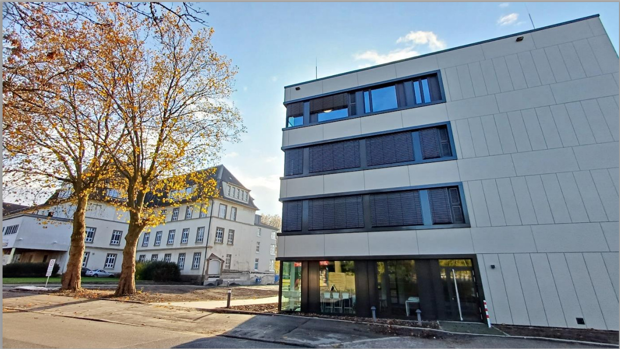
Abbildung 40 Neubau der „BIGEST-Pflegeschule“ in Bochum-Gerthe (Foto © Kohlengräberland)
