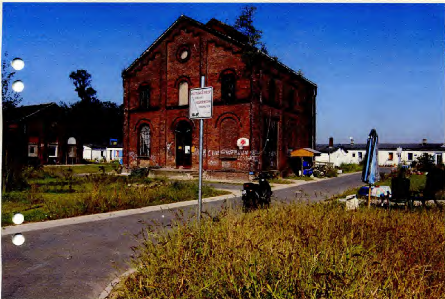
ehem. Elektrozentrale der ehem. Zwangsarbeitersiedlung Gewerkenstraße 12
